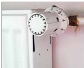
Thermostatventil auf Stufe zwei. Foto: Verbraucherzentrale Rheinland-Pfalz e.V.
