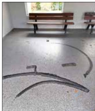
Nach etwas längerer „Ruhe“ wurde der Boden der Buswartehalle erheblich zerstört. Wahrscheinlich zwischen dem 19. und 21. November, hat ein Moped oder ein kleineres Motorrad seine Spuren auf dem Boden hinterlassen. Der Abrieb der Reifen hat sich in den Boden eingeebrannt. Daher muss die Oberfläche des Bodens erneuert werden. Dabei entstehen Kosten von ca. 1.500 €.
