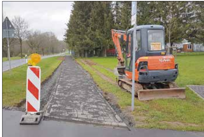
Verbundpflaster verlegt
