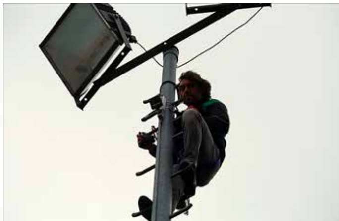
Michael Kadel bei der Installation
