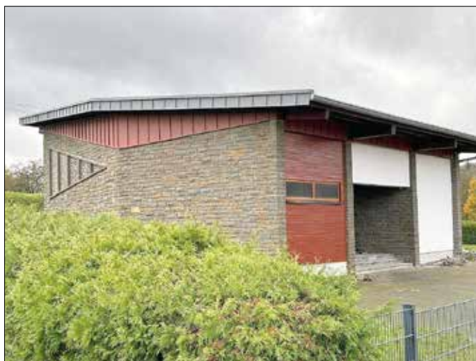
Fertig saniert Front- und Ostseite (Oktober 2023) Bildrechte (alle Fotos): Christian Benner
