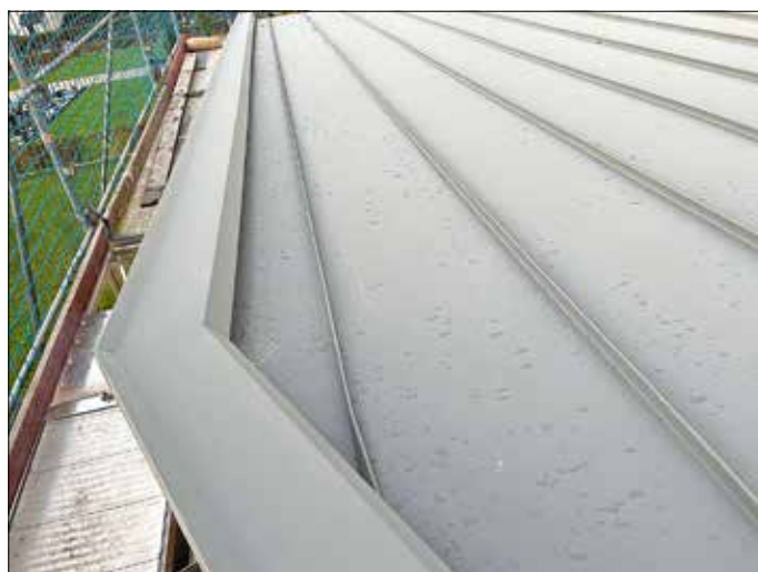
Detail Attikaverlauf und Dachflache mit den Scharen
