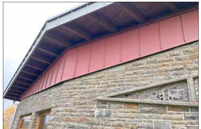
Detail Westseite am Knick
