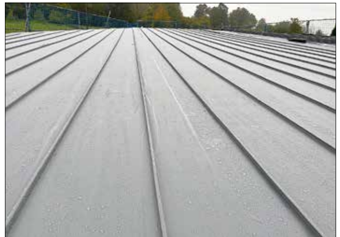
Dachfläche mit den Scharen
