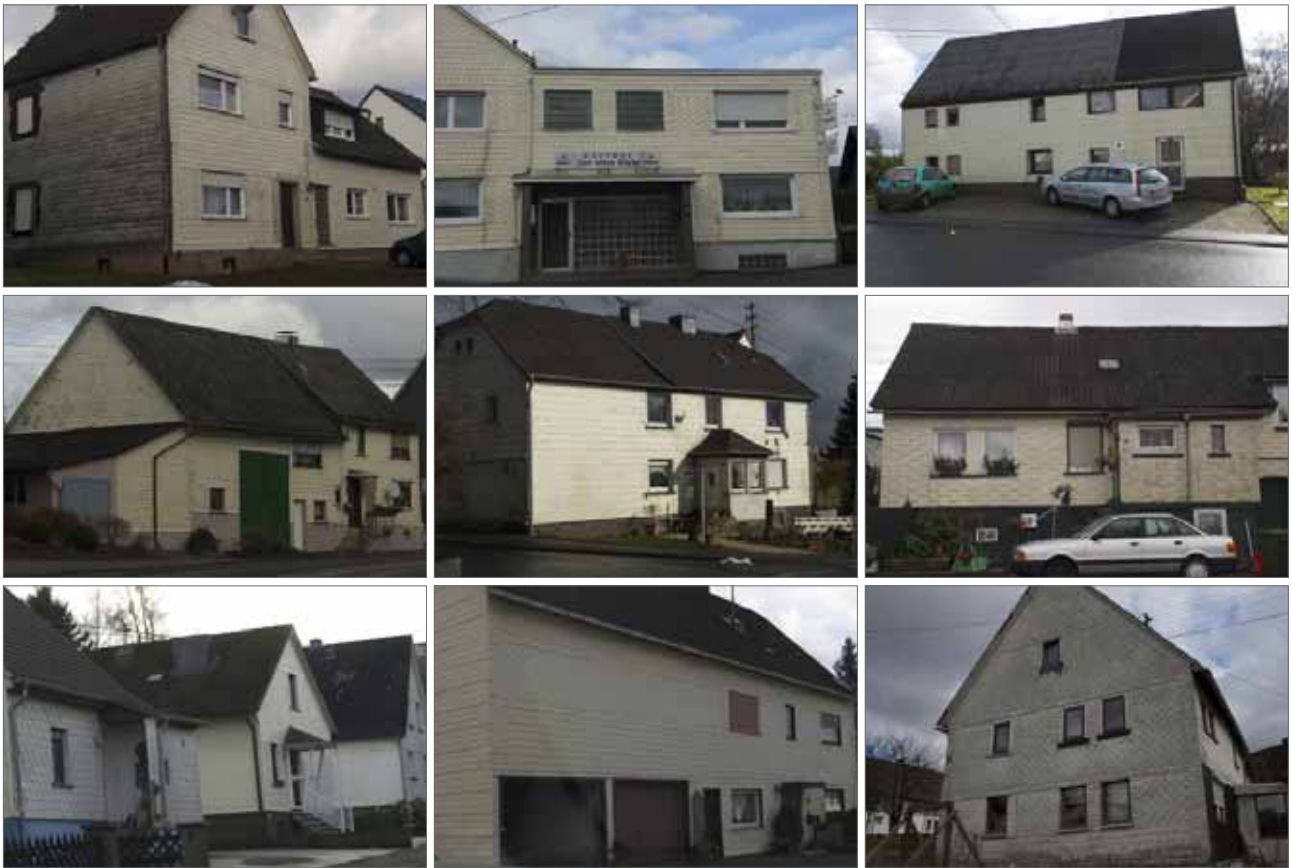
Eternitfassaden als ortsbildbestimmendes Element in der Verbandsgemeinde Bad Marienberg, Fotos: Kernplan
