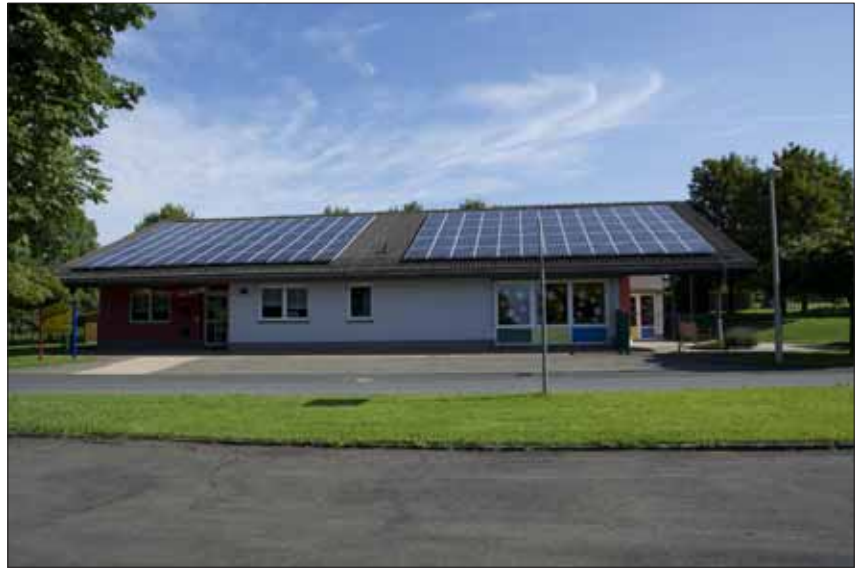
Fotovoltaikanlage KITA Fehl-Ritzhausen
