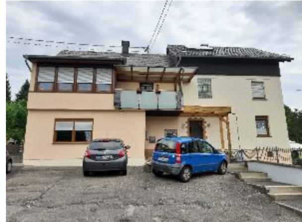
Stark versiegelt Hoffläche ohne Begrünung
