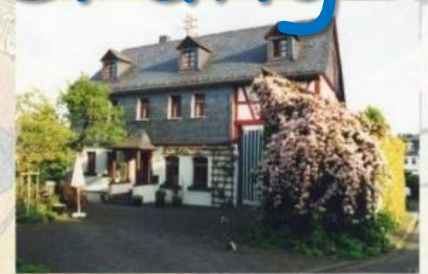
Nach der mit Dorferneuerungsmitteln geförderten Sanierung, 2000
