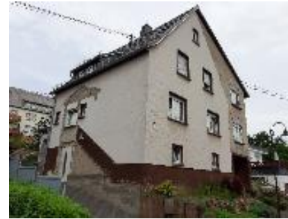
Stark überformtes historisches Gebäude
