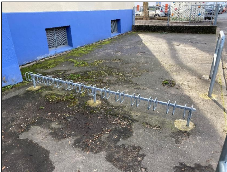
Abbildung 18: Beispiel für ungeeignete Radabstellanlagen: Fehlende Standsicherheit und zu enge Abstände können zu Beschädigung am Rad führen.
