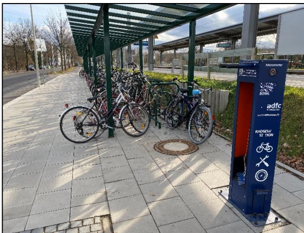
Abbildung 19: Überdachte Radabstellanlage mit Servicestation.
