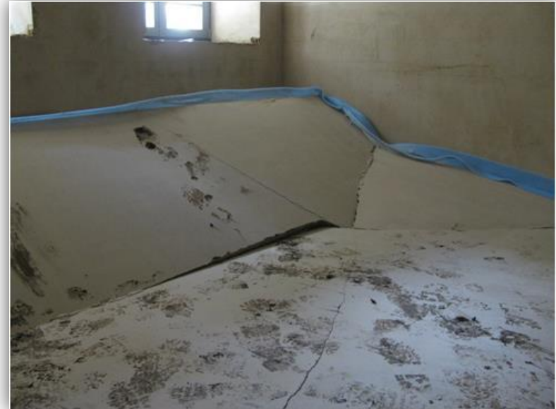
Anhydritestrich / Quellverformung
