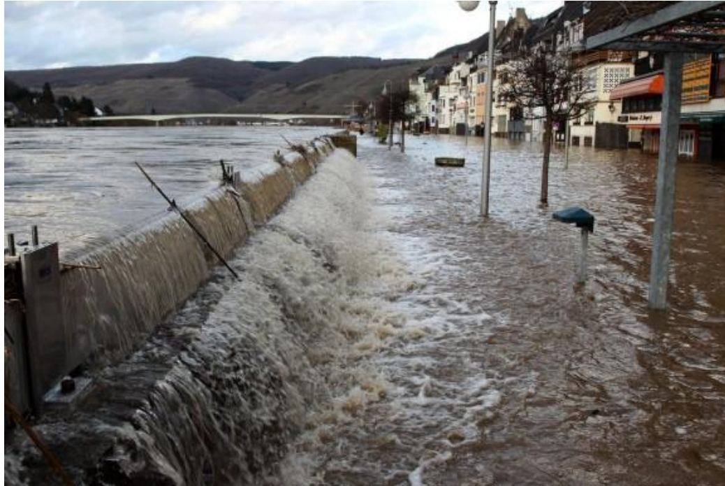
Überströmte Hochwasserschutzwand in Zell an der Mosel
