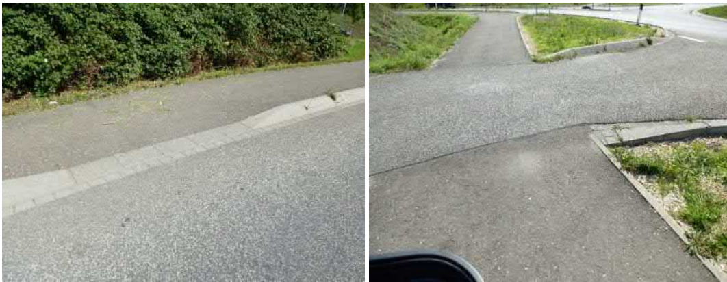
Abbildung 31: B 50 - Bordsteinabsenkung auf „Null“ und Radweg niveaugleich durchasphaltiert
