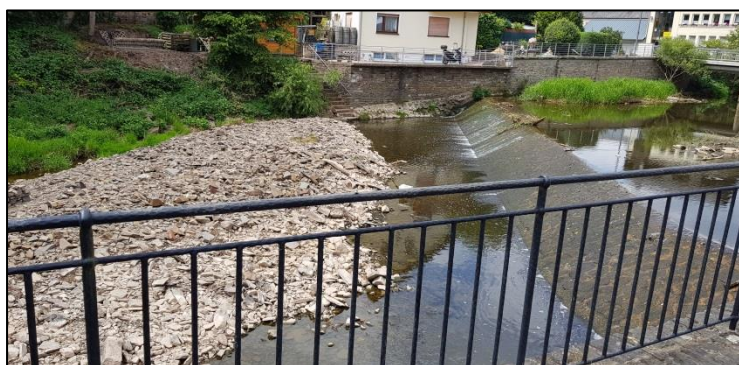
Wehr in Waxweiler vor Umsetzung der Maßnahme. Foto: Kreisverwaltung Bitburg-Prüm.
