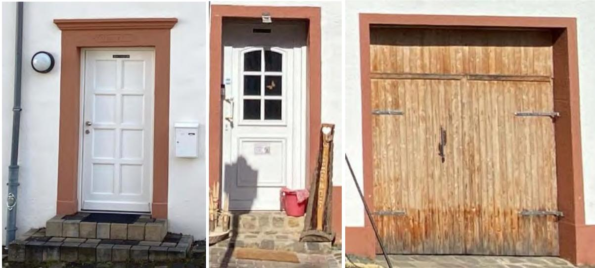
Abbildung 16: Beispiele zweier Eingangsbereiche: links weiße Holztür mit rötlichen Sandsteingewänden, Gesims und Schriftzug, in der Mitte weiße Holztür mit Glaselement und rötlichen Sandsteingewänden. Rechts Scheunentor aus Holz (Quelle: Eigene Aufnahmen)
