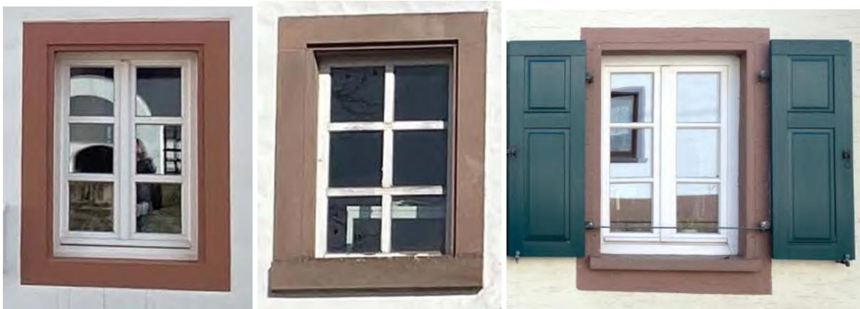
Abbildung 15: Beispiele zweiflügeliger weißer Holzsprossenfenster: links und in der Mitte mit rötlichen Sandsteingewänden, rechts sind die Klappläden noch gut erhalten, allerdings ist die Putzfasche nicht ausgeführt worden und die Fensterumrahmung lediglich durch einen Farbanstrich hergestellt
