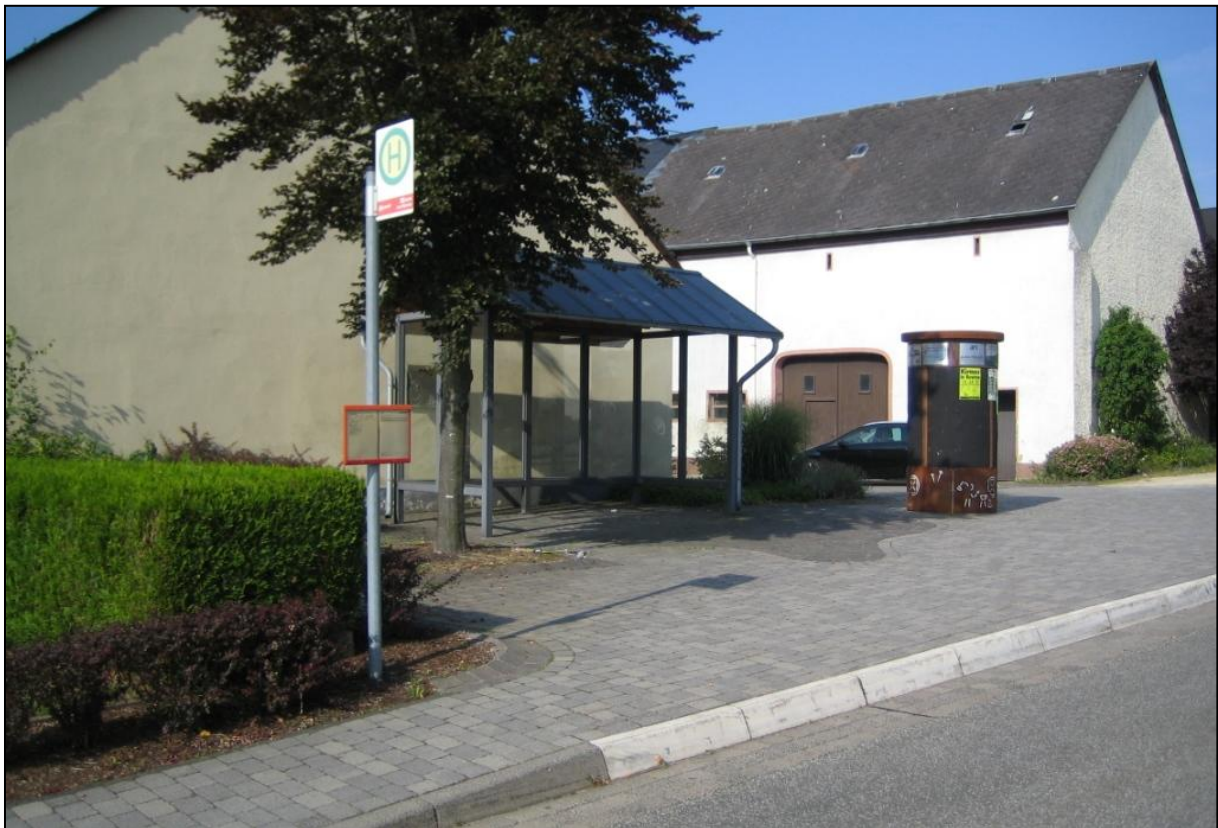
Abbildung: Bushaltestelle in Ortsmitte Quelle: Eigene Aufnahme
