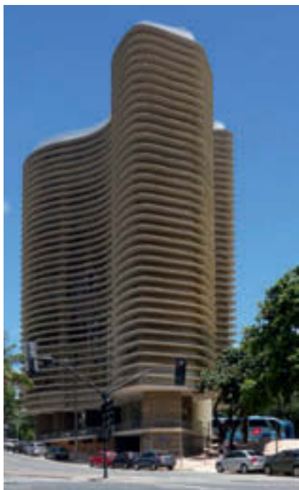
Wohnhochhaus Niemeyer Praca Liberdade in Belo Horizonte (Foto: Werner Bäuerle)
