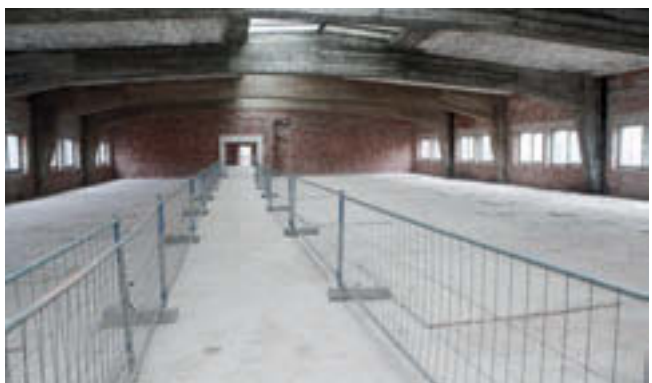
Hier wird die neue lichtdurchflutete Bibliothek entstehen (Foto: Grub)
