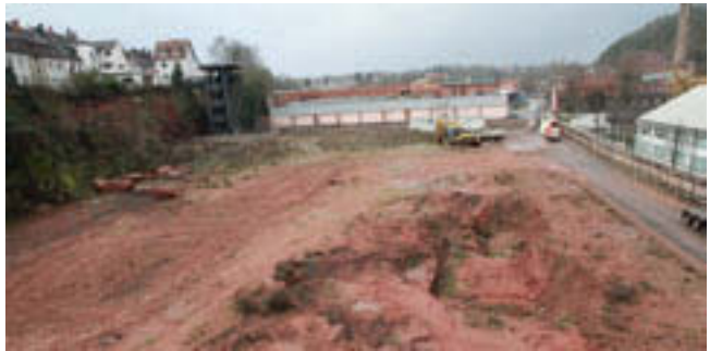
Blick auf die Freifläche auf der das Verwaltungsgebäude und die Mensa entstehen sollen (Foto: Grub)
