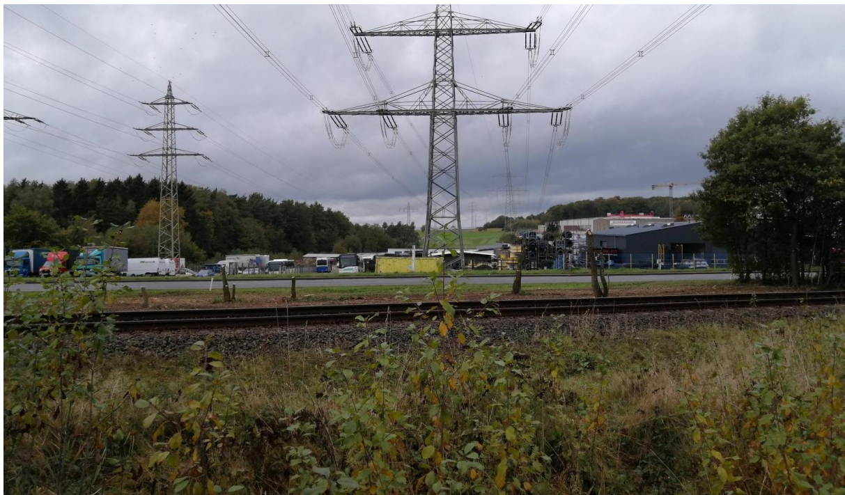
Blick über die Kabeltrasse Bereich E B westlich Bahnstrecke, Tage nach einer Mulchung
