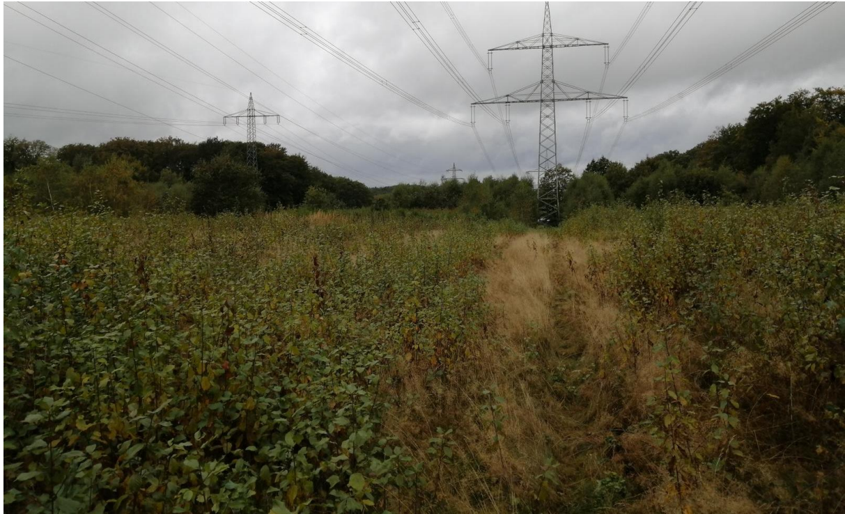
Blick über die Kabeltrasse Bereich E B inmitten einjährigen Aufwuchses
