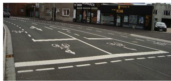
Abbildung 46: Aufgeweitete Radaufstellstreifen
