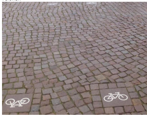
Abbildung 42: Leitelemente für Radfahrer in Fußgängerbereichen
