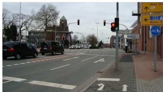
Abbildung 50: Radfahrschleuse am Knotenpunkt
