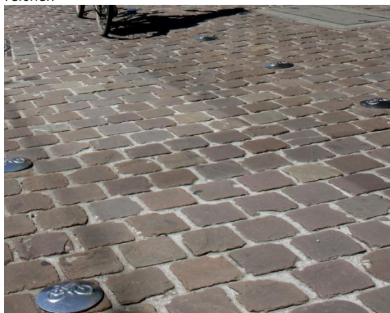
Abbildung 41: Leitelemente für Radfahrer in Fußgängerbereichen
