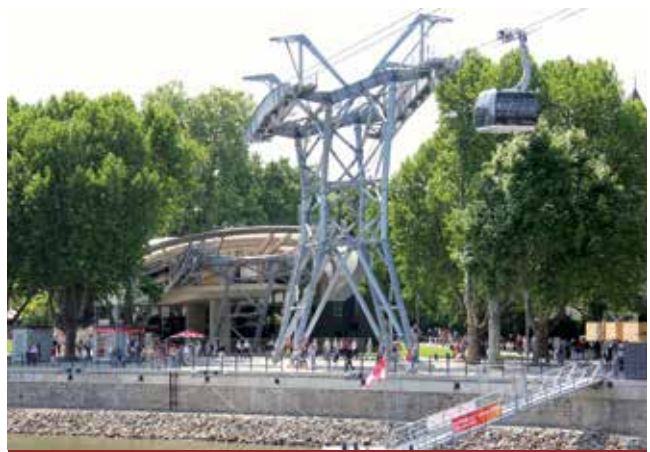
Die Seilbahn Koblenz wurde als Verkehrsverbindung zur Bundesgartenschau 2011 gebaut. Die Seilbahn verbindet seit Juni 2010 die Anlagen in Höhe der Basilika St. Kastor mit dem Plateau vor der Festung Ehrenbreitstein.
