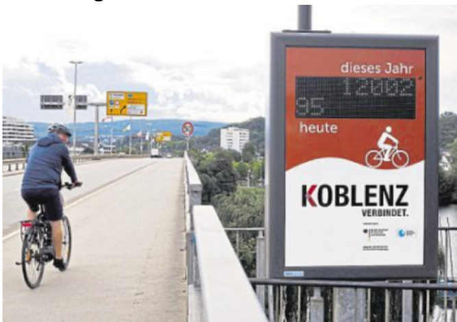
Das Radzählgerät am Treppenaufgang zur Kurt-Schumacher-Brücke in Metternich ist bereits aktiv.
