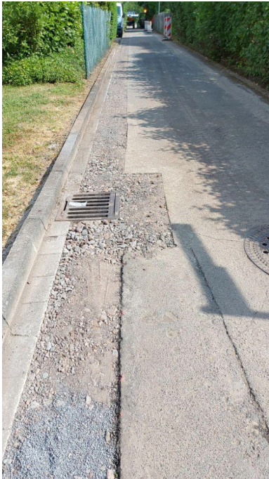
Abbildung 1: Mit Schotter prov. verschlossener Längsgraben in Asphalt
