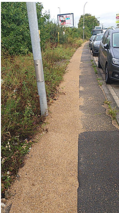
Abbildung 3: Mit Kalksplitt prov. verschlossener Graben in Asphalt
