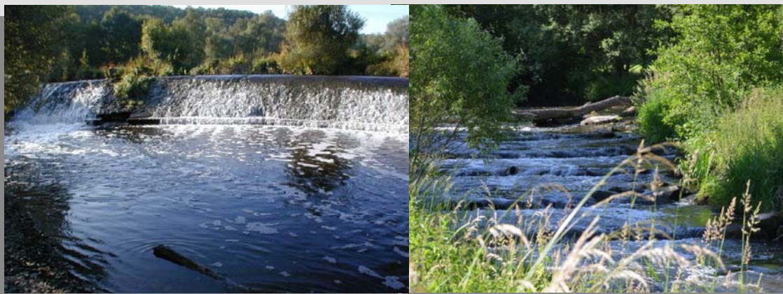
Haagsmühle Plaidt – vor und nach dem Wehrrückbau
