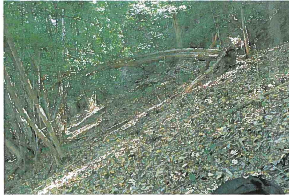
Detailfoto aus Abschnitt B, die Hangoberfläche ist mit Schutt bedeckt, im Hang befinden sich bereits umgekippte und abgestorbene Bäume
