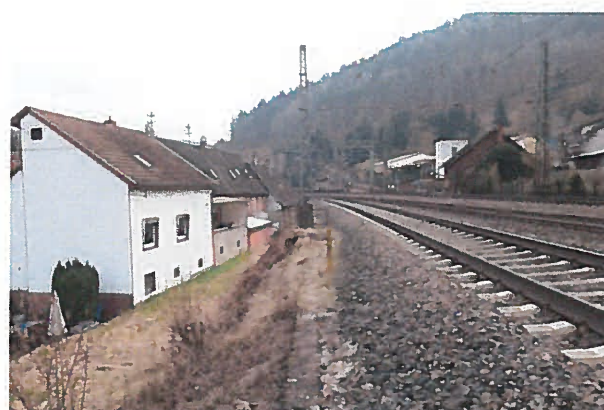
Abb. 2: Blick entlang der Trasse nach Südosten in Richtung Bahnhof Weidenthal
