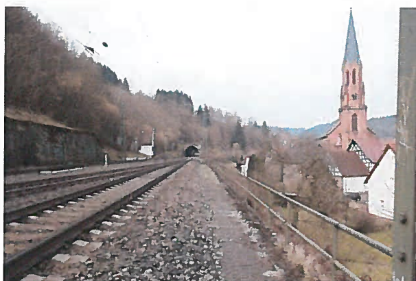
Abb. 1: Blick entlang der Trasse in Richtung Nordwesten zum Portal des Gipptunnels
