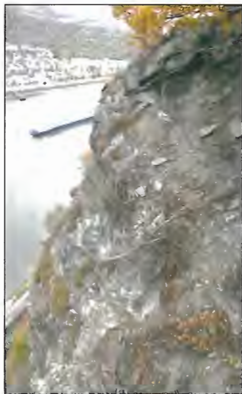
Detailfoto von Messpunkt 4, Schuttauflage auf einer Berme, im oberen Teil ist ein plattiger Block zu sehen.
