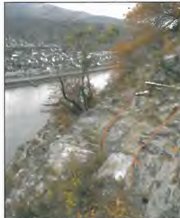
Detailfoto von Messpunkt 4: mit brauner Markierung hangparallele K1 Klüfte.
