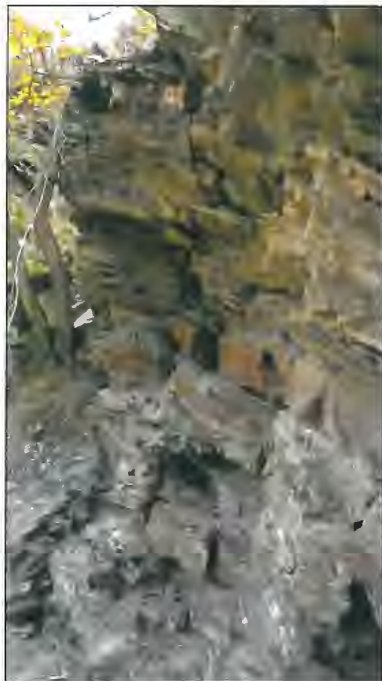
Detailfoto am Messpunkt 2. Ausbrechen kleiner Gesteinsblöcke
