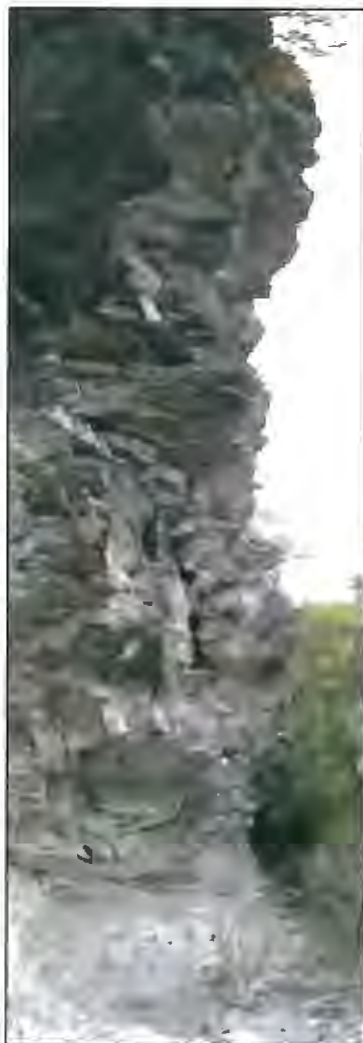
Detailfoto von Messpunkt 12 am Fuß der Felsböschung: Kleiner Überhang; Gestein stark aufgelockert.
