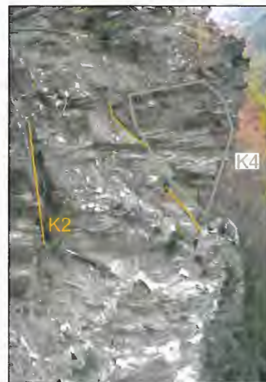
Detailfoto am Messpunkt 3. Blick auf die K4 Ebene. Block durch K2 hinterschnitten. Fels stark entfestigt.
