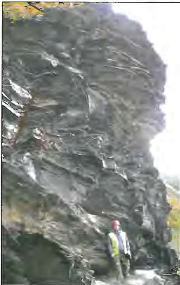
Detailfoto von Messpunkt 19: K1 verläuft böschungsparell, Verschneidung K2-K3 - kinematisch Gleiten möglich, Überhangbildung unterhalb kompetenten Sandstein-/ Quarzit-Horizonten - Steinschlaggefährdung
