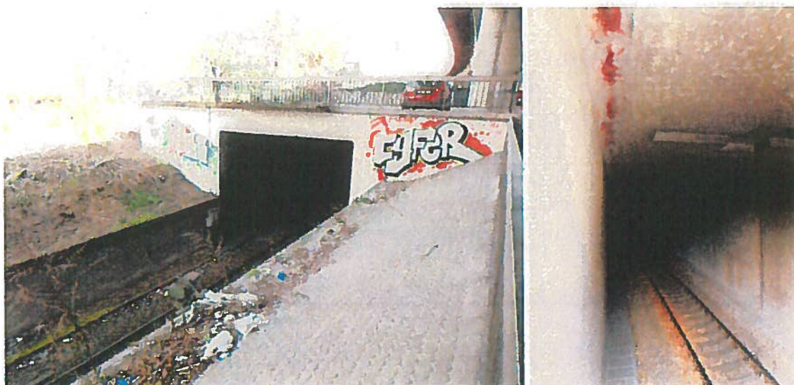
Abb. 5: Südlicher Tunneleingang (Kastenprofil mit oberseits abgerundeten Kanten) (linke Seite) und Blick in den Innenbereich mit glatten Betonwänden (rechte Seite).
