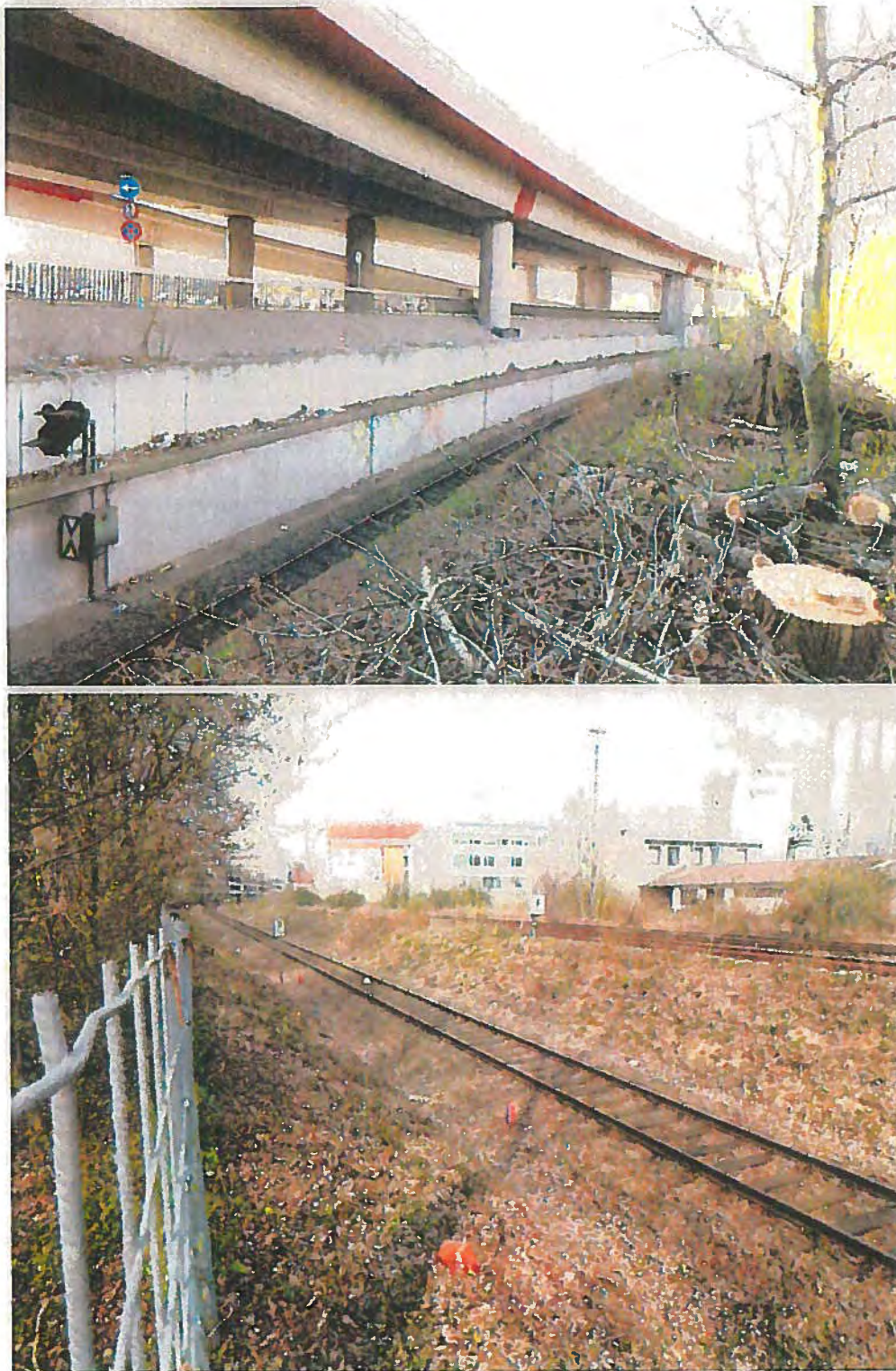
Abb. 2: Im naturfernen Umfeld des südlichen Tunnelleingangs wurden Maßnahmen zur Verkehrssicherung durchgeführt (oben). Das Umfeld des nördlichen Streckenabschnitts ist weitgehend baumfrei (unten).
