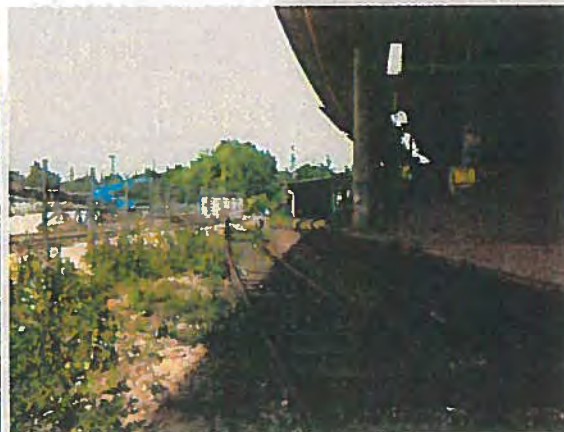
Gleisbereich im äußersten Westen des südlichen Teilabschnitts mit Blickrichtung Nordosten
