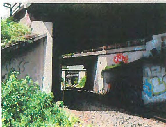
Mehrfache Untertunnelung der BASF-Südanbindung
