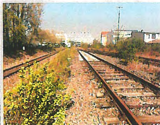
Blick Richtung Norden auf das BASF-Werk; das Gleis links im Bild ist noch in Betrieb, der Teil rechts ist stillgelegt
