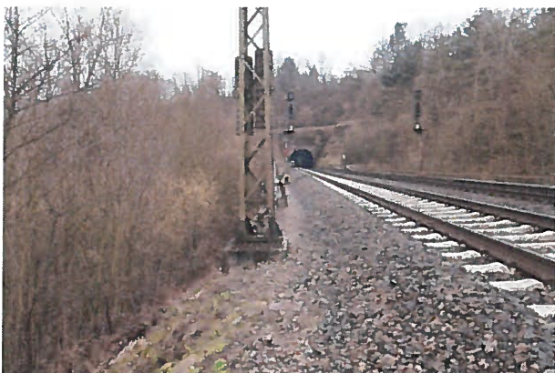
Abb. 1: Blick entlang der Trasse in Richtung Süden zum Portal des Köpfl-Tunnel
