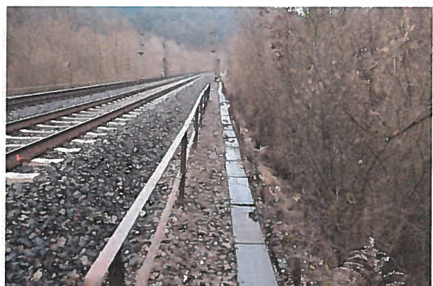
Abb. 2: Blick entlang der Trasse nach Norden
