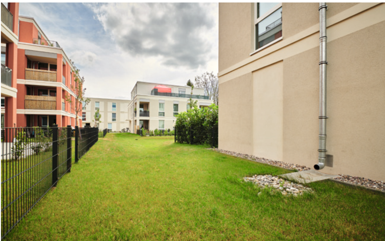
Dezentrale Rückhaltung von Niederschlagswasser
