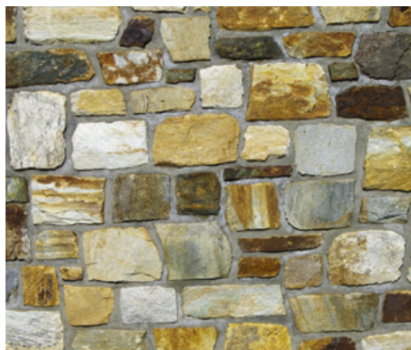
Unregelmäßiges Natursteinmauerwerk
