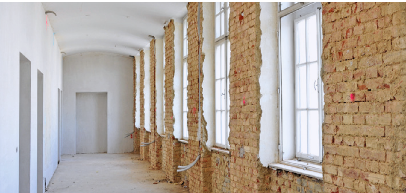
Entfernter Putz zur besseren Trocknung einer Außenwand
