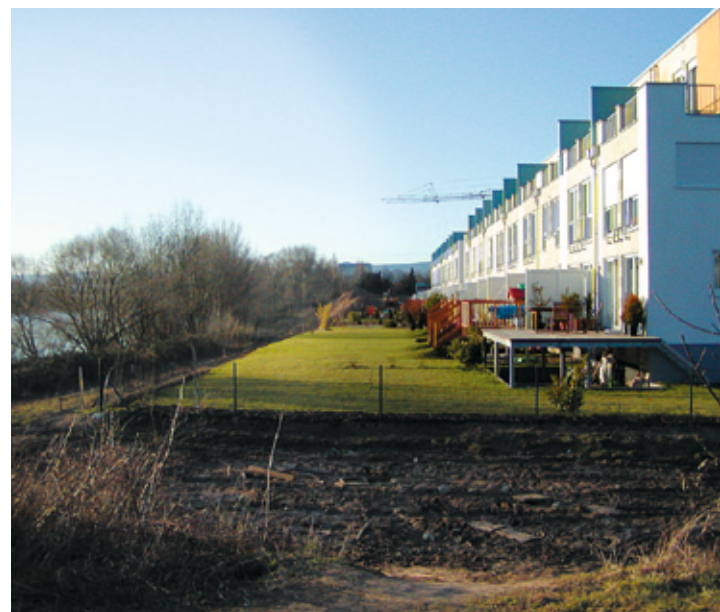
Hochwasserangepasste Bauweise mit erhöhtem Erdgeschoss
