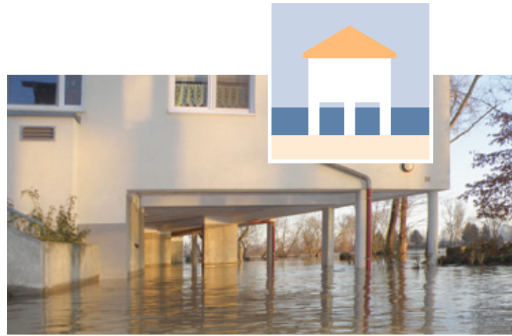
Ausweichen: zum Beispiel durch Aufständern von Gebäuden
