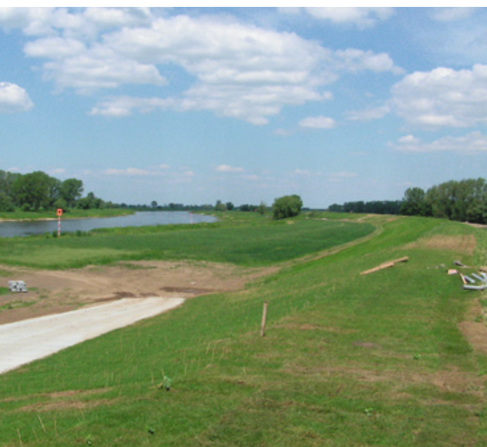
Sanierter Hochwasserschutzdeich an der Elbe
