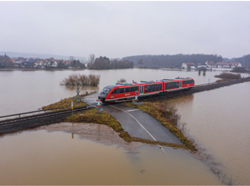
Hochwasser nach extremen Niederschlägen
