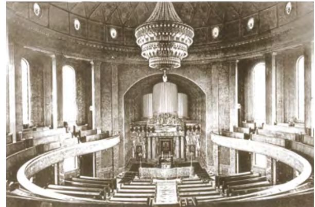
Ehemalige Hauptsynagoge, Betsaal
