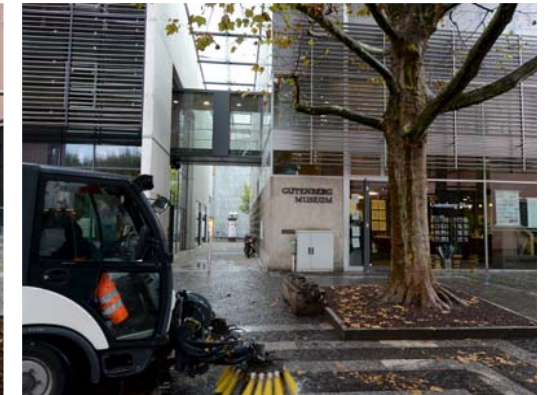
Anbindung Erweiterungsbaus ungenügend
