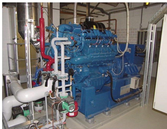
ein Modul des Blockheizkraftwerks
