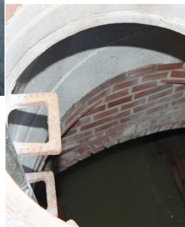
Kanalschacht in Klinkersteinen und Beton
