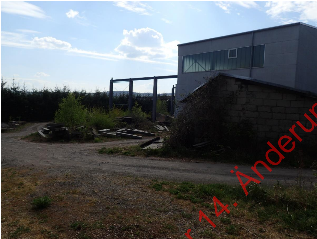
Bild 23: Blick auf die Ostseite des Gewerbegebäudes
