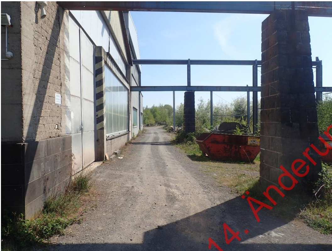
Bild 17: Blick entlang der Betriebshalle im Südosten
