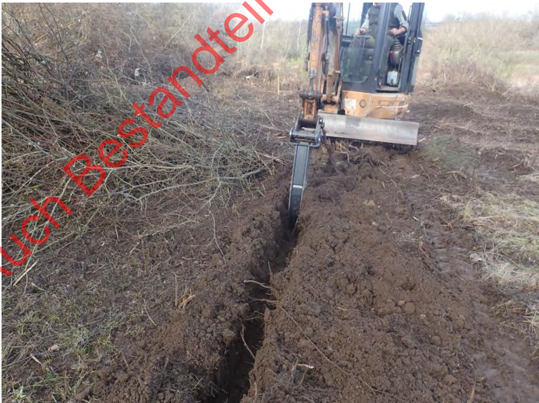
Bild 13: Ziehen einer Furche zum Einlassen der Rhizomsperre (02.02.2022)
