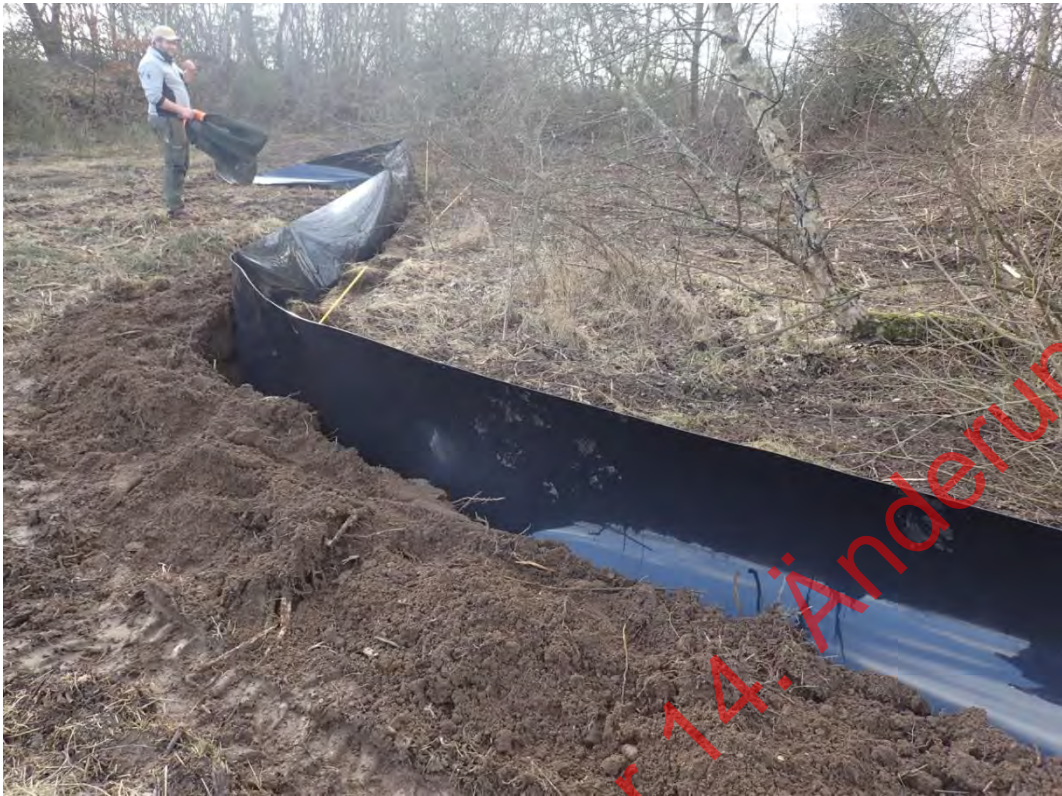
Bild 14: Einsetzen der Rhizomsperre (02.02.2022)
