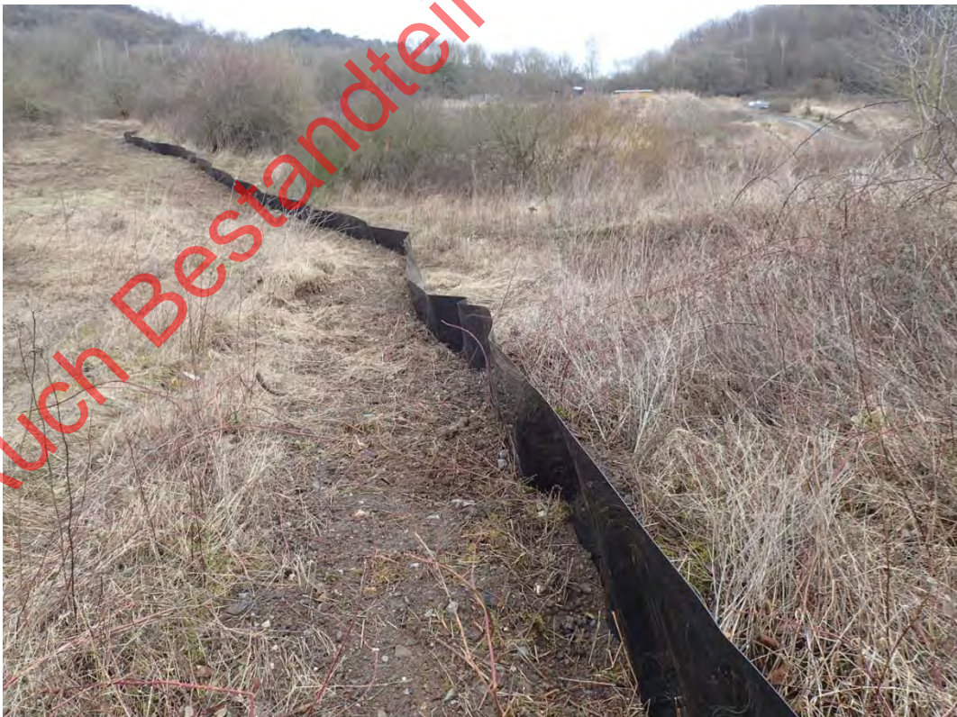
Bild 17: Fertig gestellte Rhizomsperr auf dem Deponiegelände (24.02.2022)
