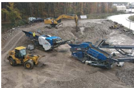
Bauschuttzubereitung Abfallwirtschaftszentrum „Auf dem Scheid“
