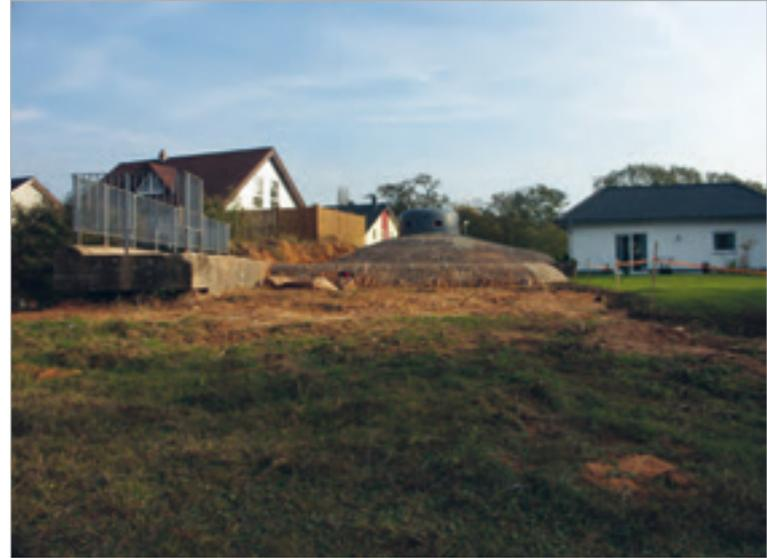
*Abb.26: Dieser unzerstörte Westwallbunker steht heute in einem Wohngebiet im Saarland. Er zählt mit einer Betonstärke von 3,50 m zu den stärksten Westwallbunkern. Zu sehen ist die Panzerglocke für zwei Maschinengewehre.*
