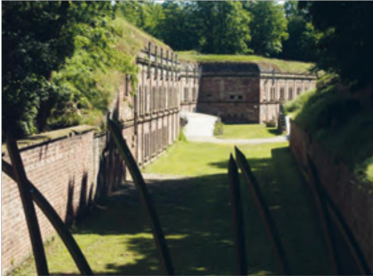
*Abb.23: Das Fort Moltke bei Straßburg gehört zum Festungsring, der vom Deutschen Reich um die Stadt gebaut wurde. Das Bild zeigt die Kehle des Forts, den hinteren Bereich mit dem Eingang, dem Kehlgraben und der zweigeschossigen Kaserne.*
