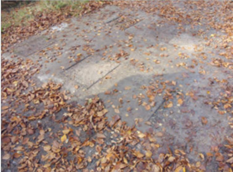
*Abb.30: Diese Betonplatte auf einer Waldstraße im Schwarzwald diente einmal zur Aufnahme einer Stecksperrre aus Stahlträgern, mit denen die Straße schnell unpassierbar gemacht werden konnte.*
