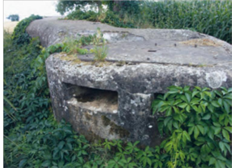
*Abb.24: Zwischen Straßburg und den Vogesen finden sich noch heute zahlreiche moderne Betonbunker aus der Armierung von 1914 in den Feldern. Das Bild zeigt einen Beobachtungsstand mit Scharten und einer Panzerplatte als Decke, in der sich eine Öffnung für ein Scherenfernrohr befindet.*
