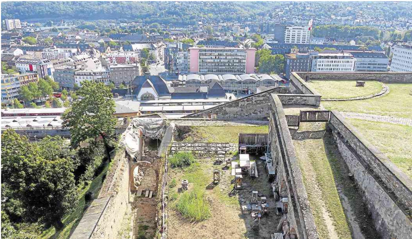
Der nördliche Bereich von Fort Konstantin Koblenz Ende August 2015. Gut zu erkennen sind die freigelegte Rampe, die Reste der Poterne und die fehlenden Basaltplatten auf der Mauerkrone. Die darüber gelegenen Bereiche sind bereits im Rahmen von früheren Sanierungsmaßnahmen erneuert und ergänzt worden.
