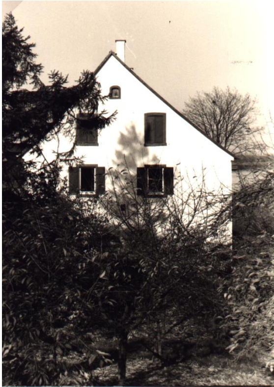
1979, die Eulenmühle, Blick von Nordosten. 2
