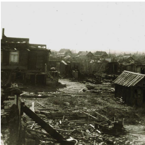
Kriegsschäden in der Ortsmitte. 21
