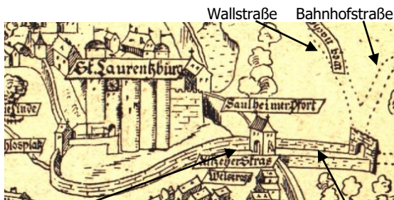
1577, Lage der südlichen Brücke über dem Burgraben.
