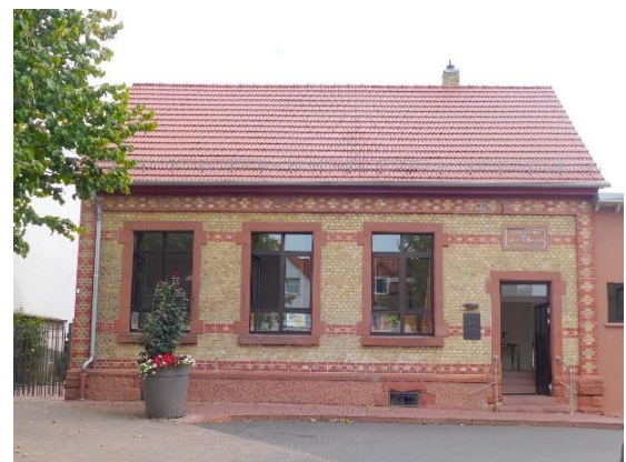
Der ehemalige Kindergarten, Pfarrgasse. 70
