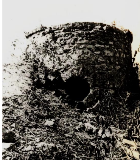
1950, Rest des an der Burgringmauer gelegenen Ostturms. 9
