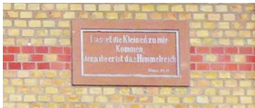
Ehem. Kindergarten, Pfarrgasse.
