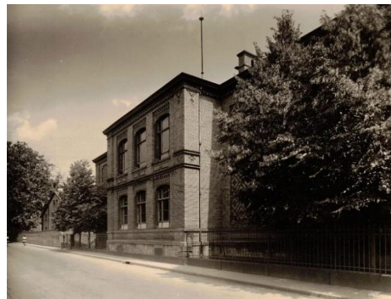
1893, Neubau der Volksschule. Die Maurerarbeiten führte Maurermeister Peter Faust II. aus. Die Einweihung des Schulhauses erfolgte 1894. 58
