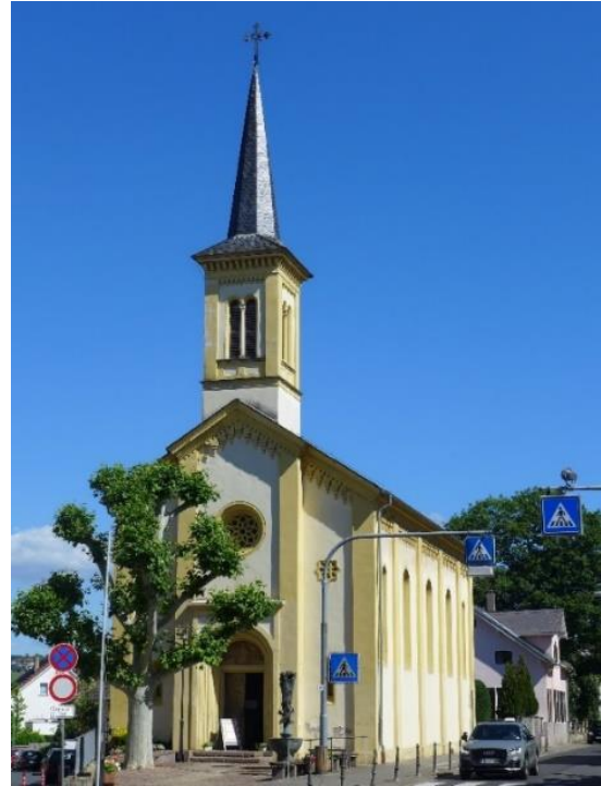
1865, Neubau der ev. Kirche. Die Maurerarbeiten führte Maurermeister Peter Faust I. aus. 56
