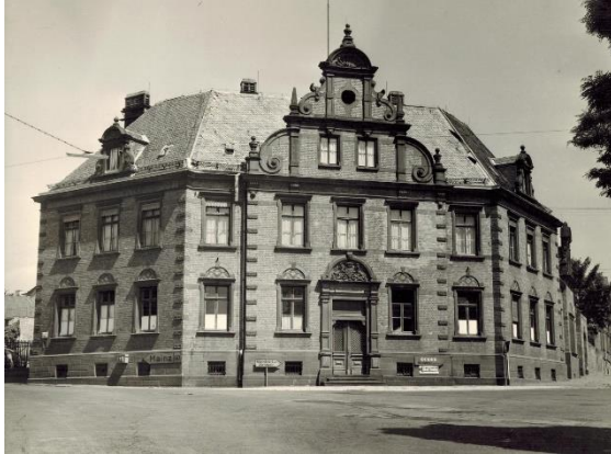
1893-1894, Neubau des Amtsgerichts, Vorderseite. 42
