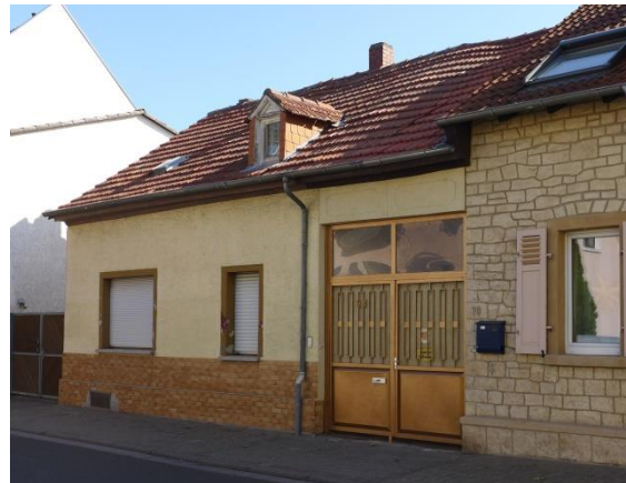
Haus der ehemaligen Uhren- und Kraftfahrzeugwerkstatt mit Tankstelle von Adam Schwarz, Pariser Straße Nr. 52. 10
