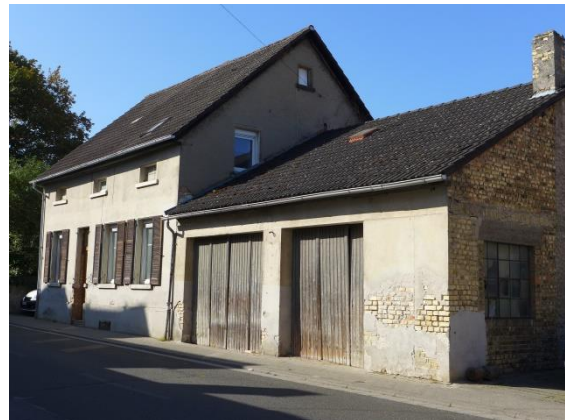
2022, Pariser Straße Nr. 69, ehemalige Kraftfahrzeugwerkstatt von Peter Beißmann. 16
