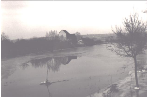
1930er Jahre, Hochwasser an der Wiesenmühle. 42
