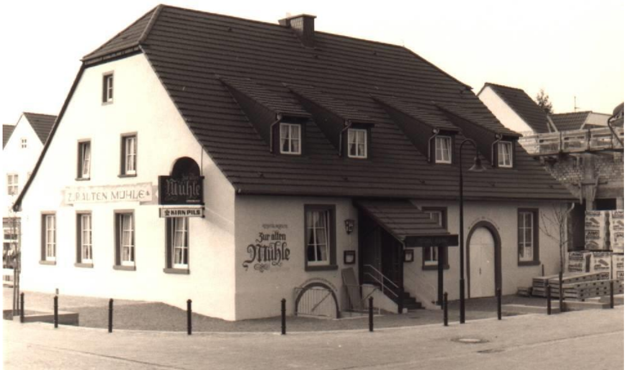
1989, Woogmühle nach der Sanierung. 40
