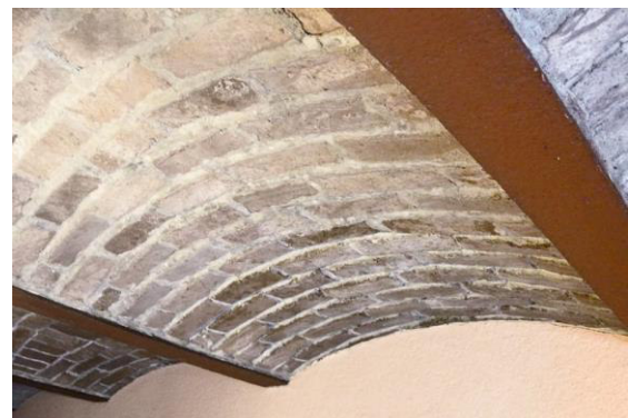
Preußische Kappendecke mit gewölbter Backsteinfüllung. 45
