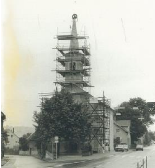
1980, Neubau des Kirchturms der evangelischen Kirche durch die Zimmerei Georg Ludwig Weisrock jr. 50
