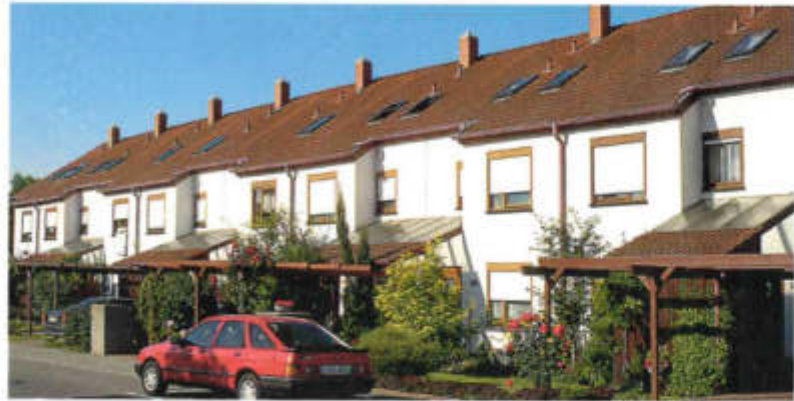
Altrip, Ziegeleistraße Planung: Roland Unold, Rubensstraße 5, Stuttgart Bauleitung: Hans Wagner, Lillengasse 2, Schifferstadt
