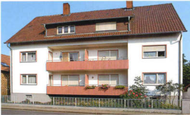
Hochdorf-Assenbeim, Langstraße 1, Gaszentralheizung, Isolierglasfenster, Badmodernisierung, Erneuerung Außenputz
