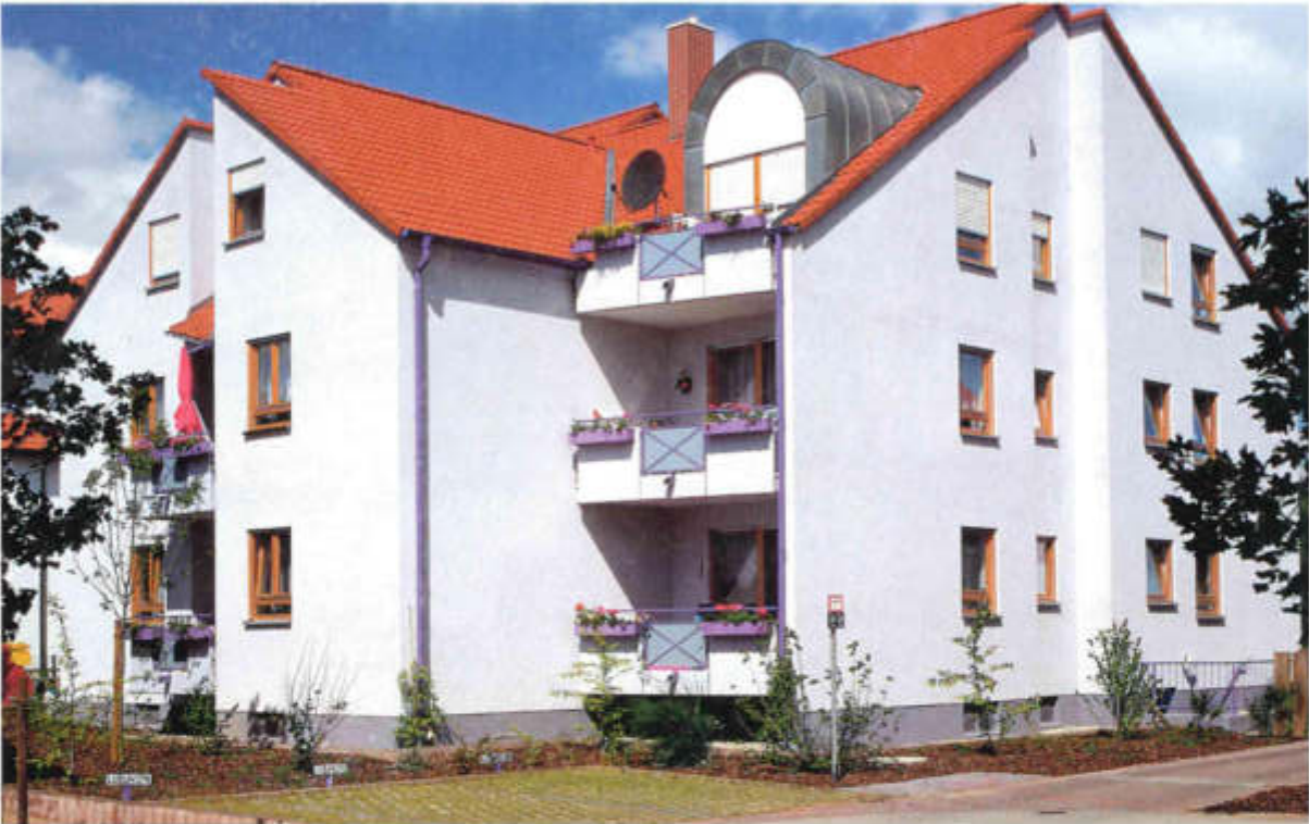
Dannstadt-Schauernheim, Martinsring 13 Planung und Bauleitung: Josef Diebl Haßlocher Straße 32 Hochdorf-Assenheim
