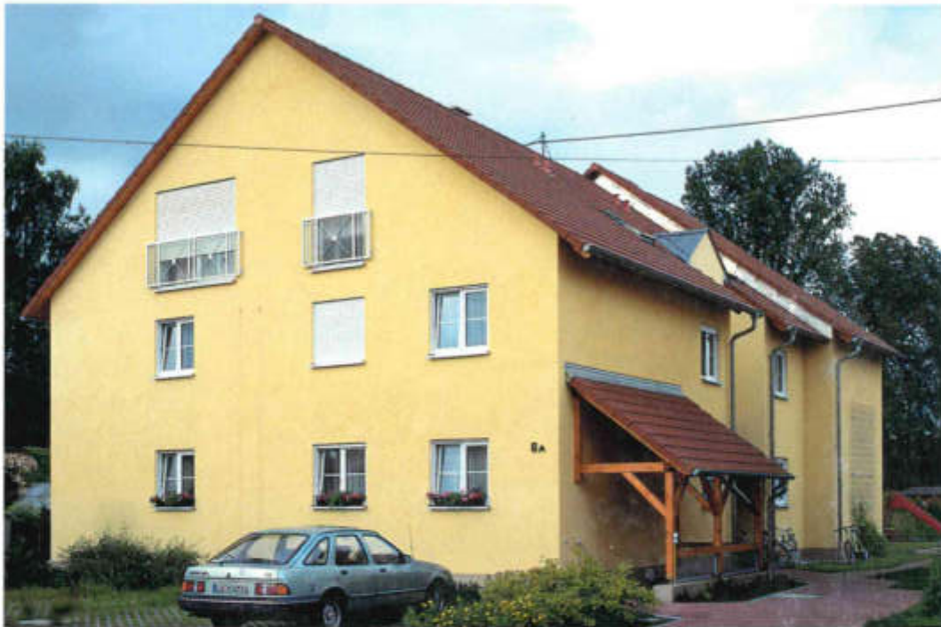
Hanbofen, Hartbäuser-Straße 6 a Planung und Bauleitung: Johannes Derwaritsch, Sallerstraße 22, Dudenbofen
