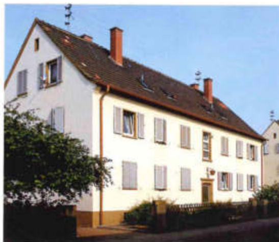
Fußgönbeim, Speyerer Str. 88 Isolierglasfenster mit neuen Klappläden, Außenanstrich, Hofbefestigung und Außenanlage
