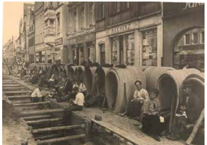
Hauptstraße wird kanalisiert - 1926
