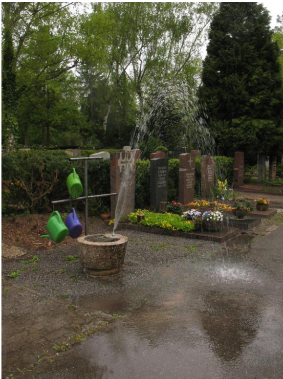
Wasserzapfstelle mit Vandalismusschaden
