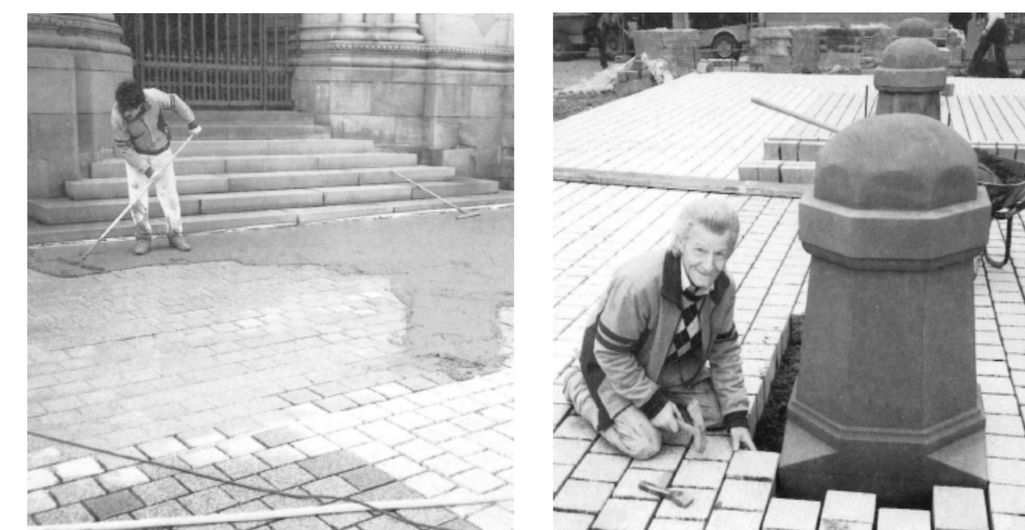
Der Domplatz während dem Umbau. Quelle: Strasse und Platz, Dokumentation Neugestaltung Maximilianstraße und Domplatz, Speyer 1989
